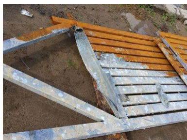
NIEPOPRAWNIE rozerwany profil – brak 1 otworu
