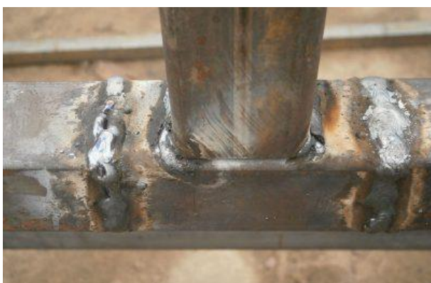
NIEPOPRAWNIE nieszczelna i niedokładnie oczyszczona ze szlaku spoina
