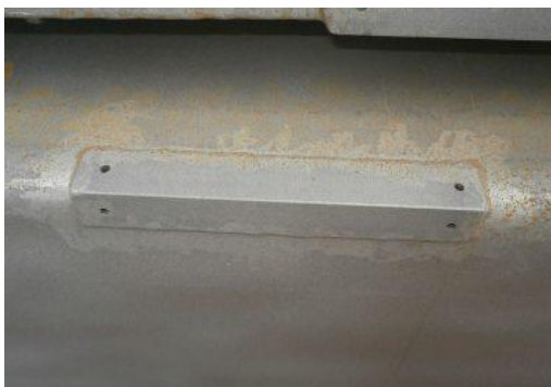
POPRAWNIE odprężenie nakładki
