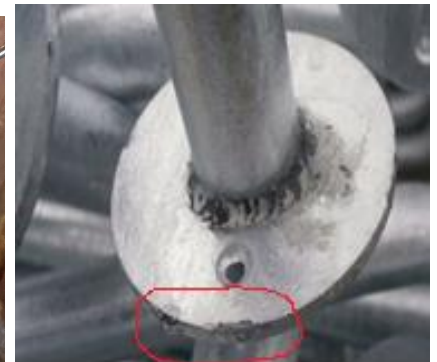
NIEPOPRAWNIE zjawisko odpryskującego cynku spowodowane przez ostre krawędzie i nieczyszczone spoiny
